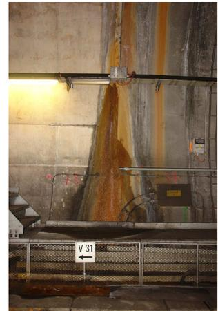
Dans le cas de la gare Part Dieu réalisée en tranchée couverte, les joints entre les différents panneaux de parois moulées seront autant de points d'infiltrations préférentiels.
