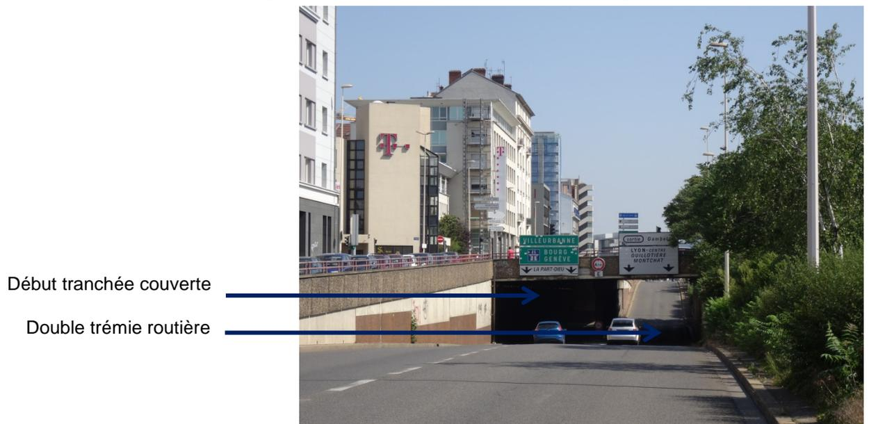
**Figure 87 – Ouvrage du tramway T4 au niveau du PRO de l’avenue des Frères Lumière**
