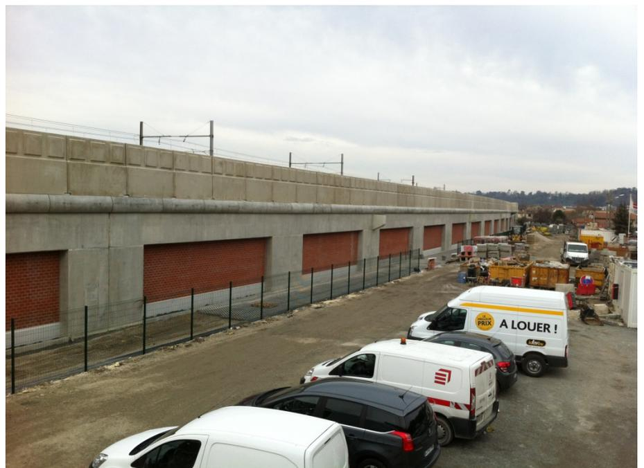
Le long du Bd Stalingrad, la largeur entre appuis permettra d’insérer 3 voies de circulations routière au niveau des carrefours, soit environ 9 m de largeur.
